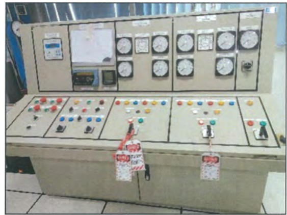
รูปที่ 88 Lock Out-Tag Out ขณะปฏิบัติงาน
