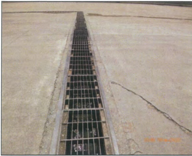
รูปที่ 63 รางระบายน้ำฝนที่ปนเปื้อน
