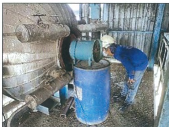
รูปที่ 86 พัดลมเป่าระบายอากาศบริเวณพื้นที่อับอากาศ
