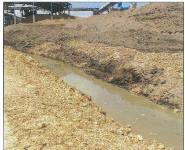
รูปที่ 39 รางระบายน้ำโดยรอบลานกอง เชื้อเพลิง และลานกองเถ้า
